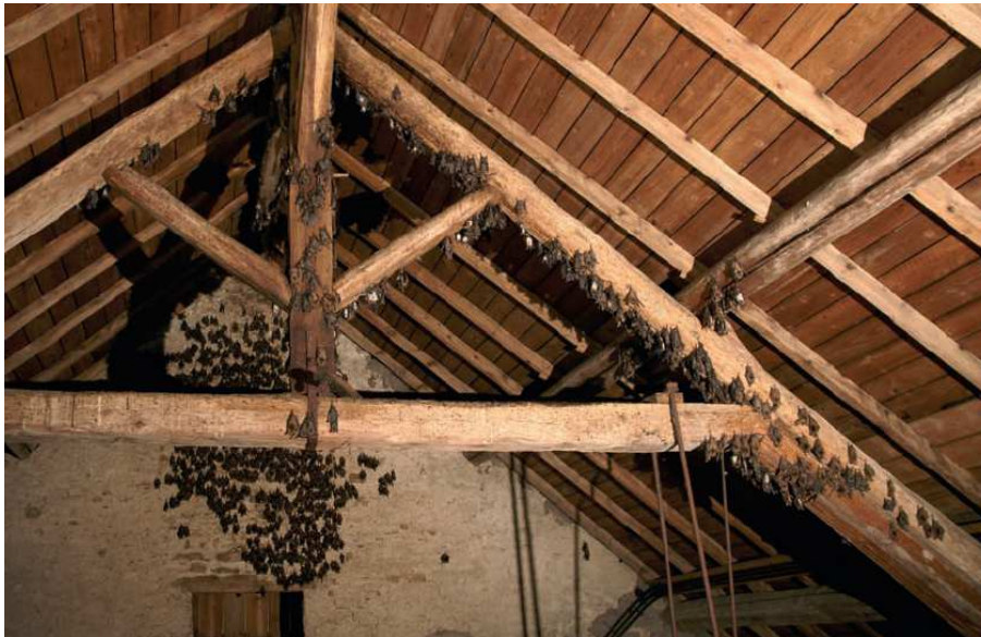
PHOTO : D. AUPERMANN - Gîte estival de reproduction dans une ancienne grange
